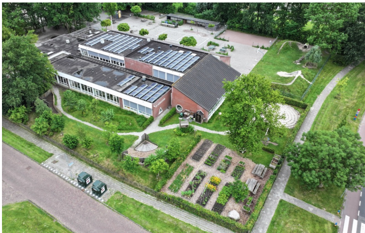
Huidig gebouw Hoeksteen ca. 1.763 m 2 bvo
